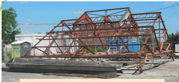
Charpente et chéneaux démontés le 11 juin 2014
